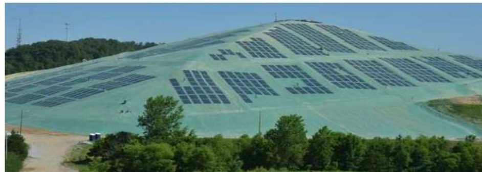
: Confronto fra la copertura tradizionale e la realizzazione di Tessman Road (US-TX)
